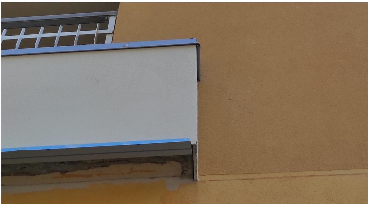
Si dispone la chiusura delle fessure sotto i balconi ai lati delle scossaline.
